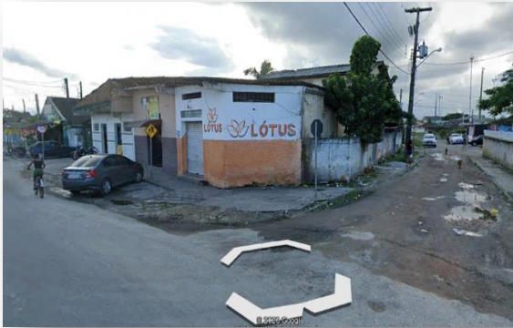
Figura 91. Pavimentação das Ruas do Entorno
