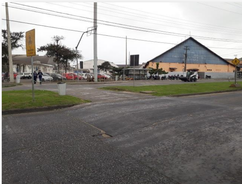
Figura 156. Faixa elevada para travessia de pedestres. Av. Portuária, bairro Dom Pedro II
