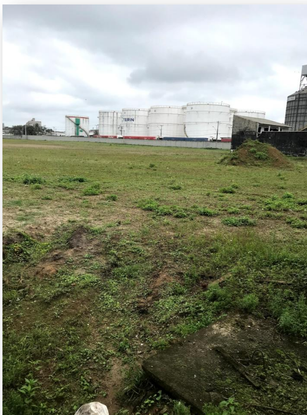
Figura 60. Ponto 1 - Atualmente a área está cercada, gramada e sem uso
