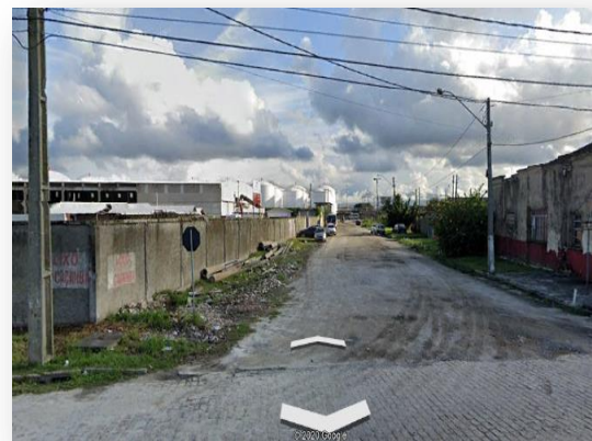
Figura 80. Vista do cruzamento e pavimentação
