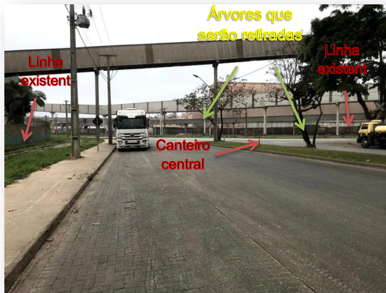
Figura 164. Interferências no local do novo trecho de linha férrea Fonte: Google Earth (2020)
