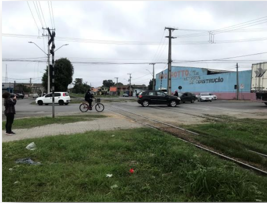
Figura 165. Cruzamento da Av. Roque Vernalha
