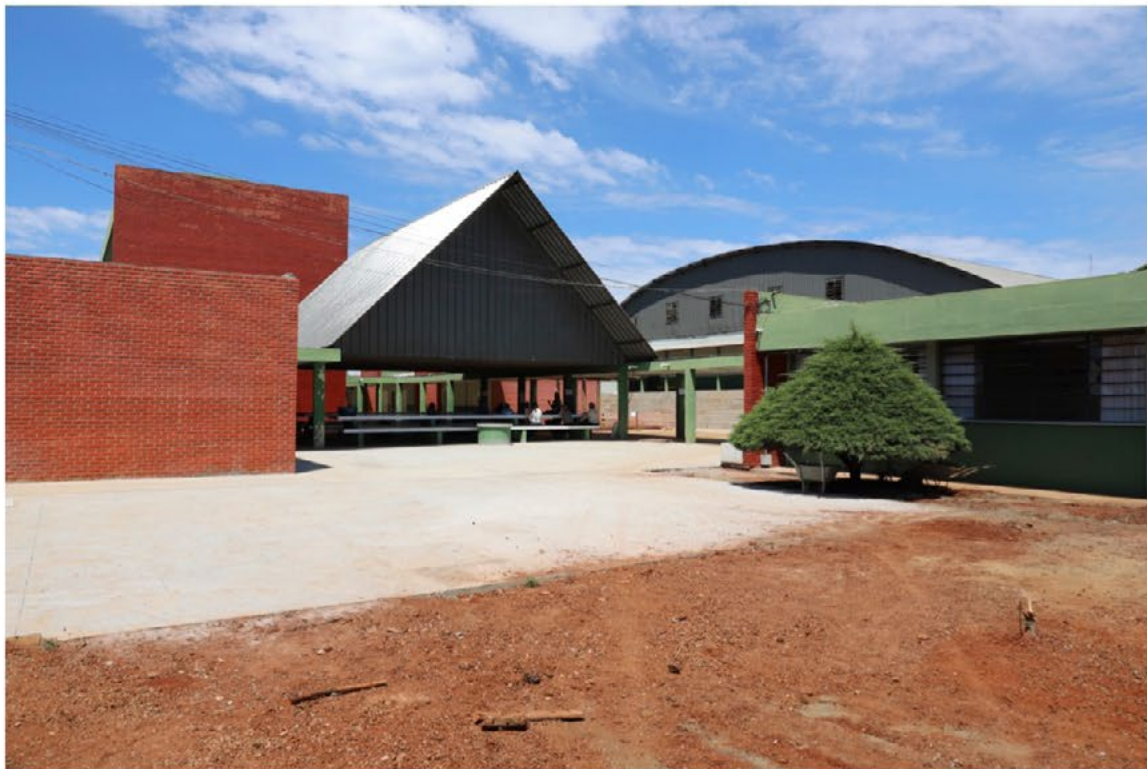
Obra no pátio do Colégio Estadual Wolff Klabin, em Telêmaco Borba (PR). Foto: Arquivo Klabin
