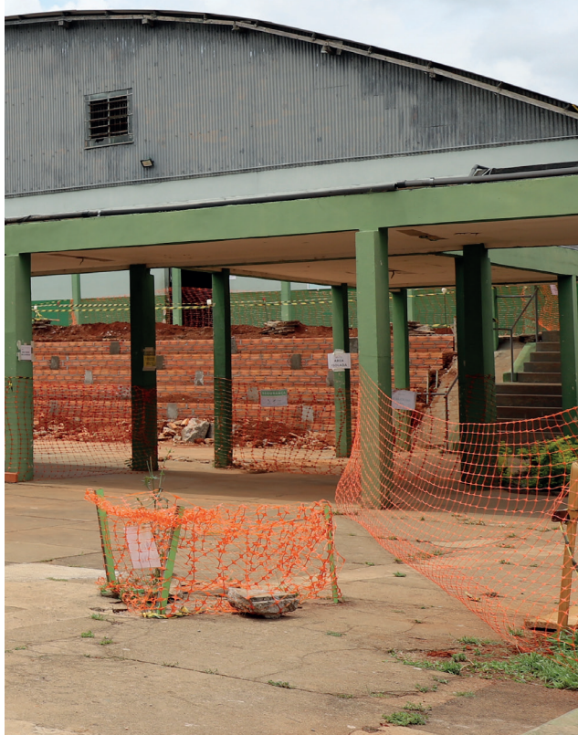
Obra no pátio do Colégio Estadual Wolff Klabin
