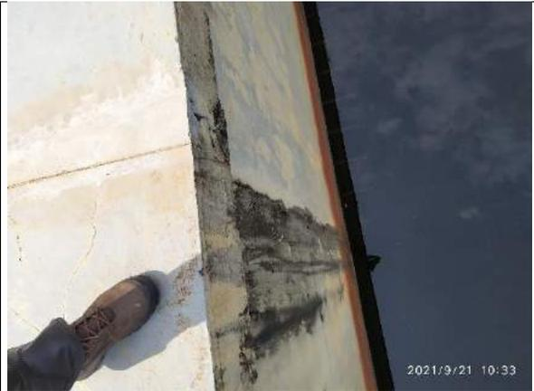
FOTO 7 - VISTA DA JUNTA DE DILATAÇÃO
