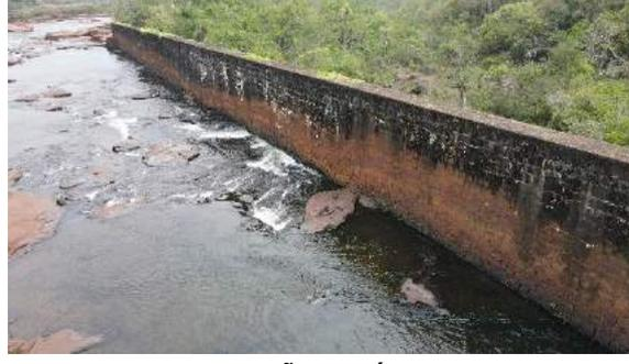
FOTO 44 – PERCOLAÇÃO DE ÁGUA E CARBONATAÇÃO.
