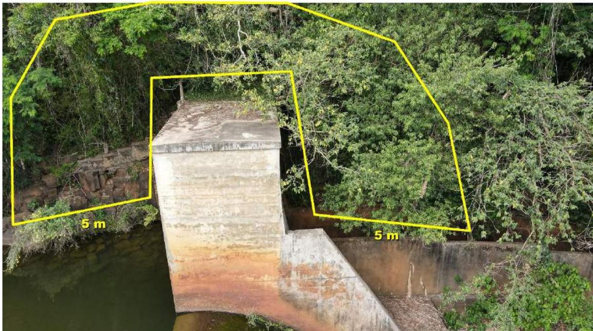
FIGURA 12. SUPRESSÃO VEGETAL AO REDOR DA OMBREIRA DA MARGEM ESQUERDA DA PCH SALTO MAUÁ.
