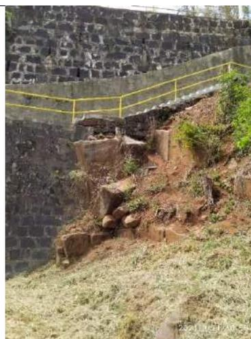
**FOTO 14 – VISTA DO TALUDE DA MARGEM DIREITA COM SOLO EXPOSTO E MURO DANIFICADO.**
