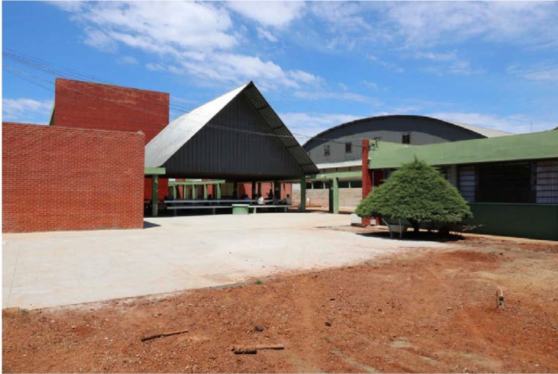
Obra en el patio del Colegio Estatal Wolff Klabin, en Telêmaco Borba (PR). Foto: Archivo Klabin
